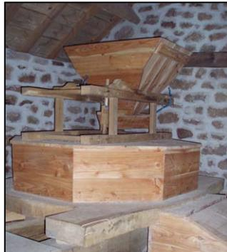
Le dispositif de chargement du grain, le coffre des 2 meules, et le bac à farine. Tout est en bois superbement ajusté.
